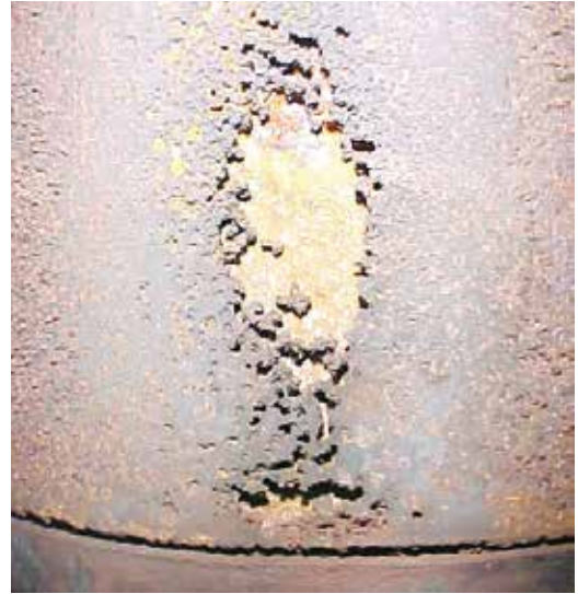
Fig. 6.1.3 Cavitação sem corrosão
