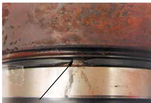
Fig. 5.2.4 Anel O'ring cortado durante a instalação da camisa no bloco
