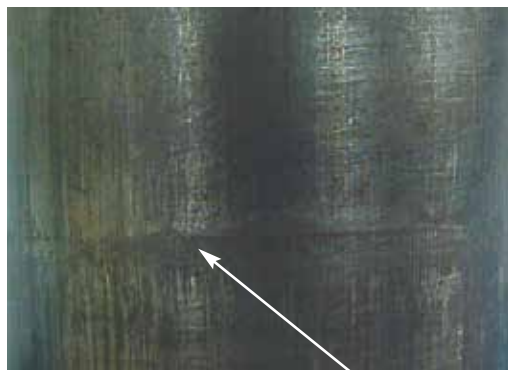
Fig. 10.3.4 Marca do embuchamento incorreto
